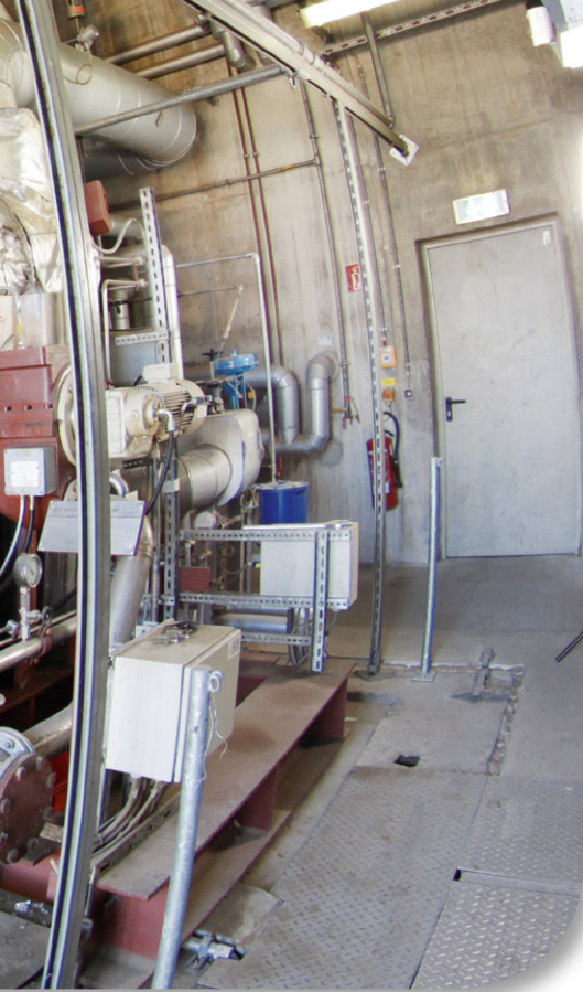
Dampfturbine und Generator
